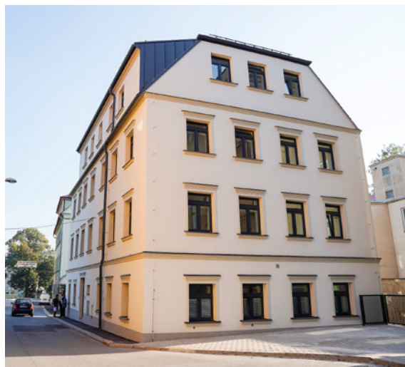
Rekonstruovaný bytový dům v Orlí ulici
