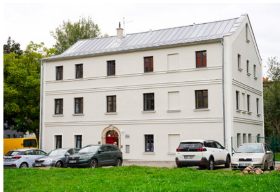
Rekonstruovaný bytový dům v Proboštské ulici
