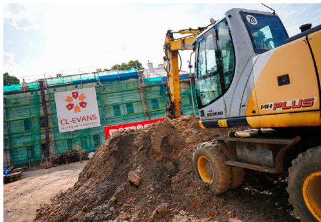
Mezi největší investiční akce města patří rekonstrukce bývalé galerie, Liebiegova paláce, na Centrum aktivního života. V říjnu proběhl jeden z kontrolních dnů stavby.
